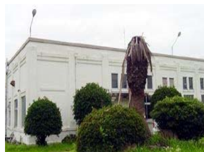
清里総合ポンプ場
