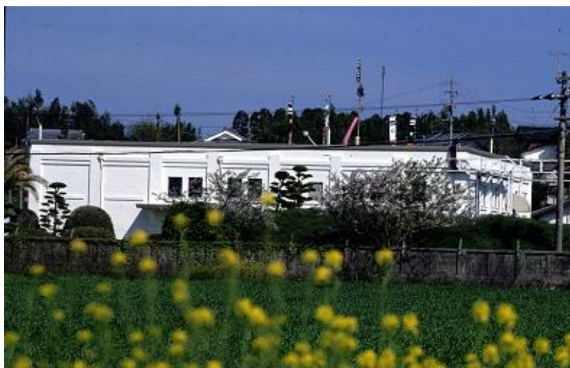
清里総合ポンプ場
