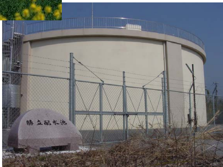
勝立配水池 (平成15年2月完成)
