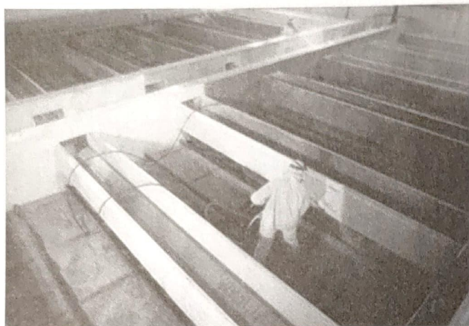
図11 急速ろ過池を徹底的に洗浄
