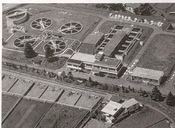
図2 クリプト事故前の急速ろ過の浄水場
